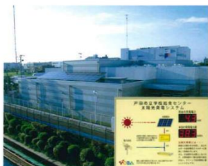
太陽光発電システム
